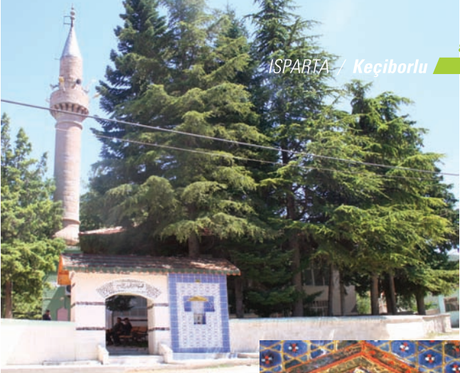
* İncesu Köyü Camii
